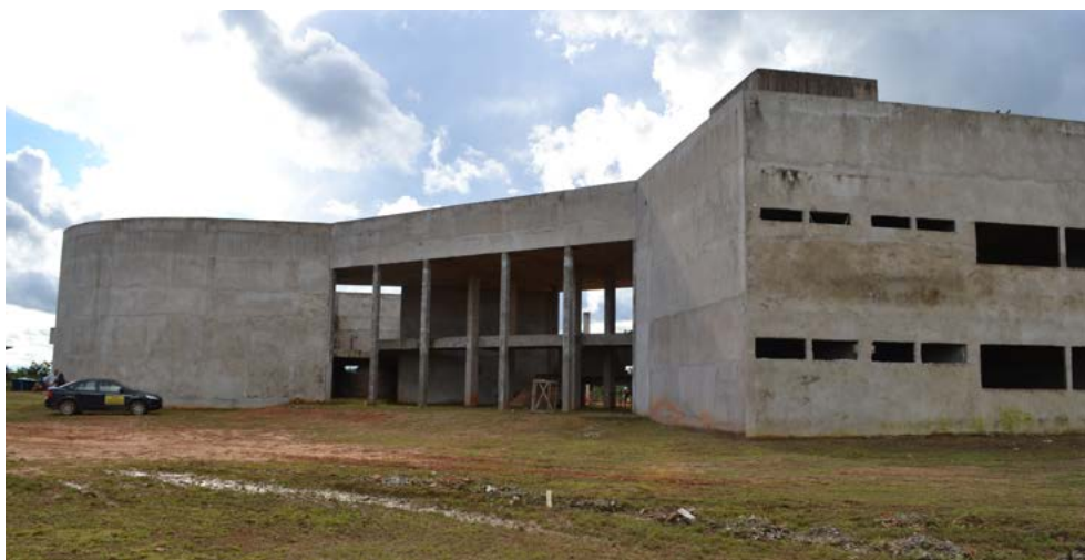
Retomada das obras da sede própria
