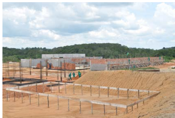
Obras do campus tiveram início em 2010
