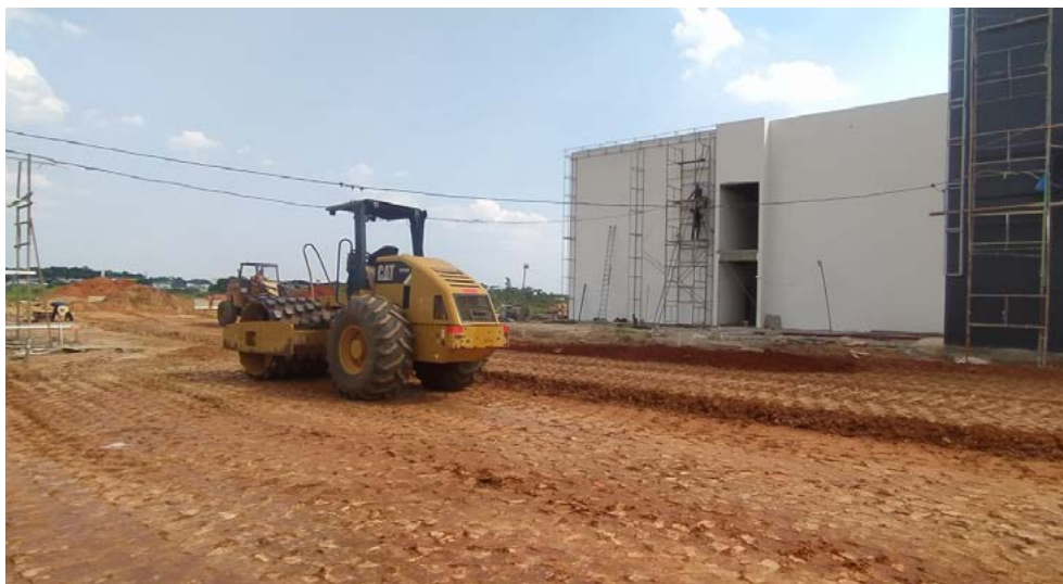
Obras da sede da Reitoria em fase de conclusão
